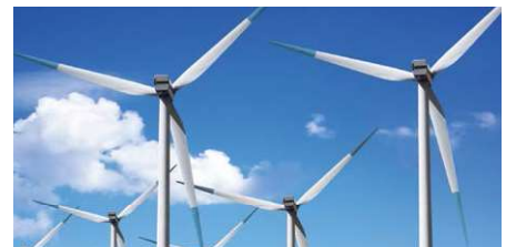
Monitoreo de velocidad de aerogeneradores
